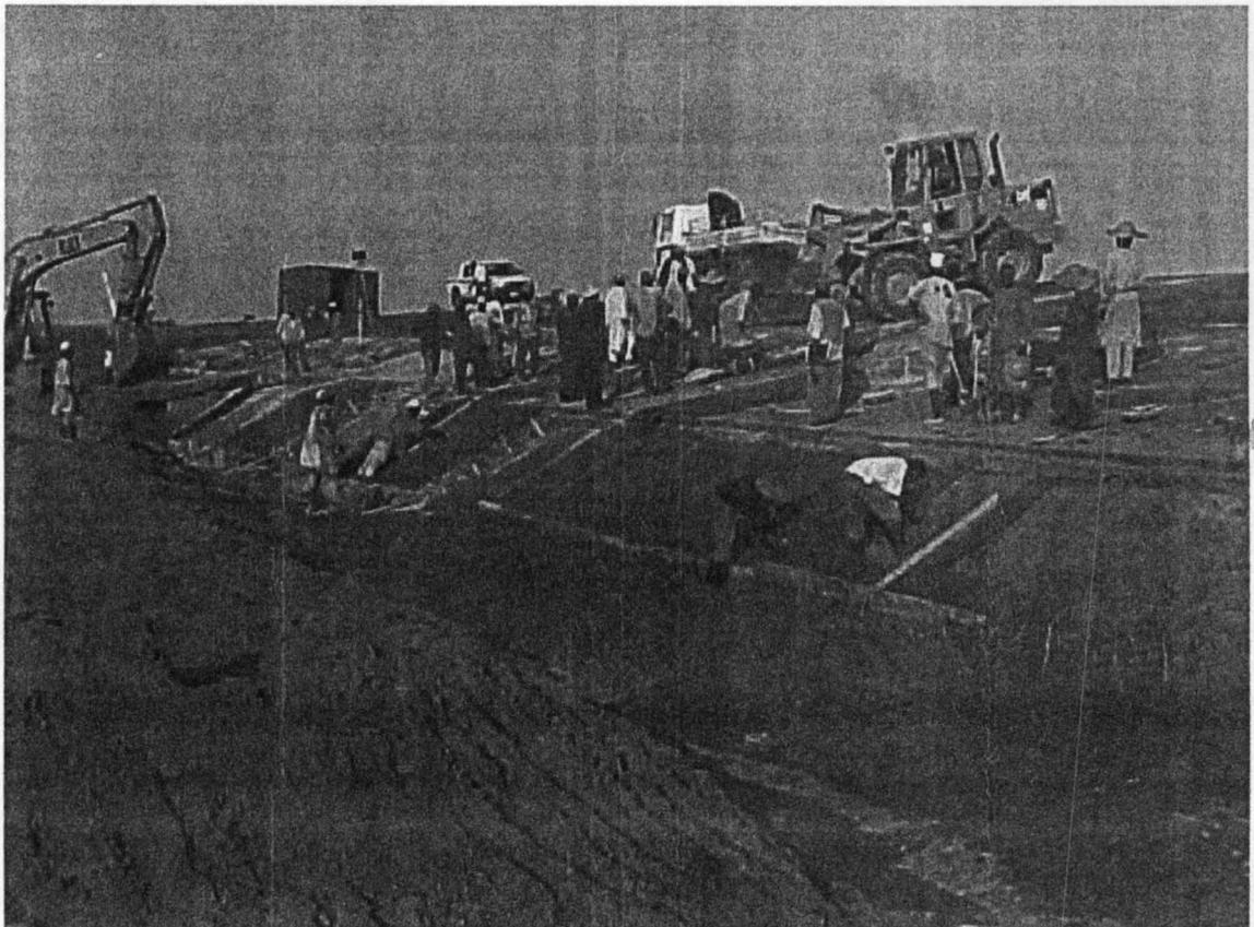
**GROUP H1** : EMERGENCY SPILLWAY; BLINDING AND CASTING OF SLAB.
