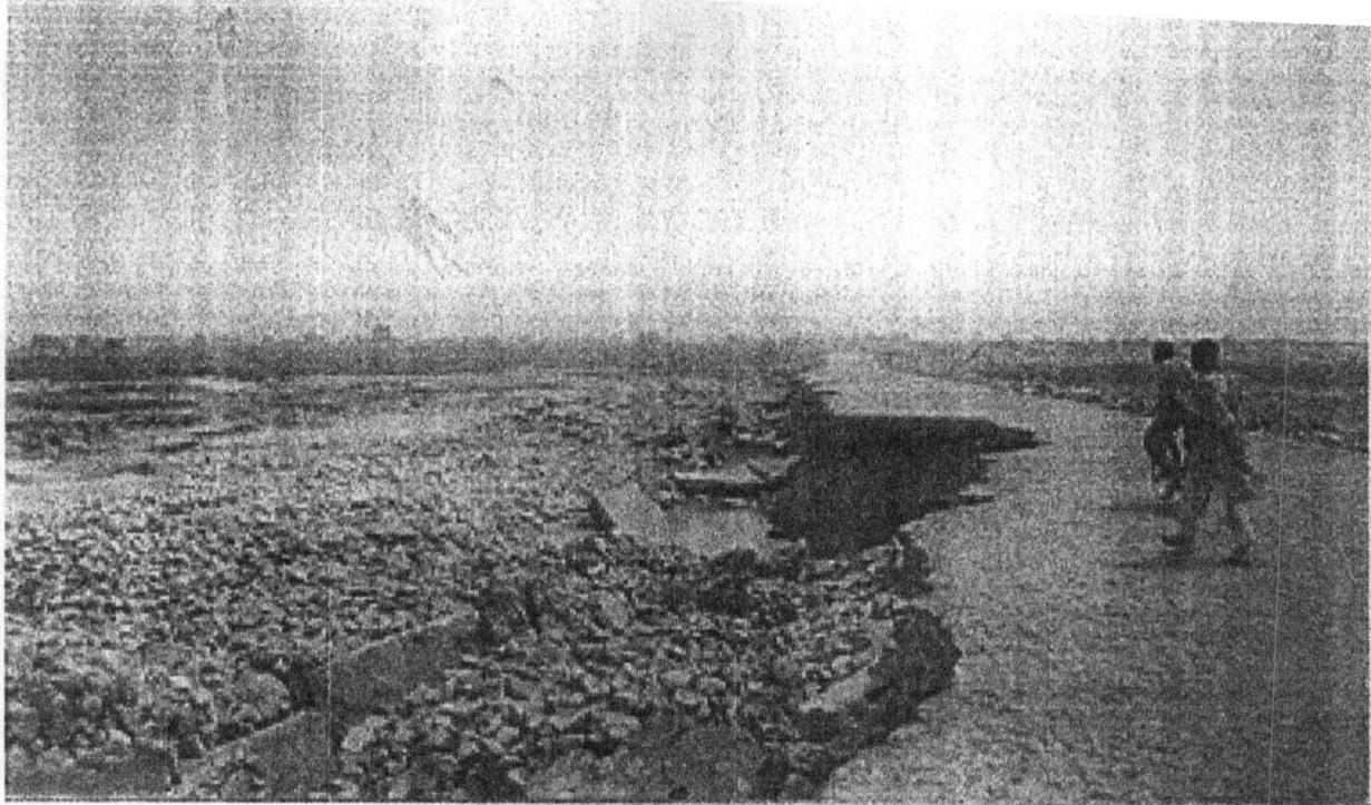
**ATE NO 3: FAILURE OF RETAINING WALL AT DOWN STREAM APPROACH CHANNEL OF THE SPILLWAY.**
