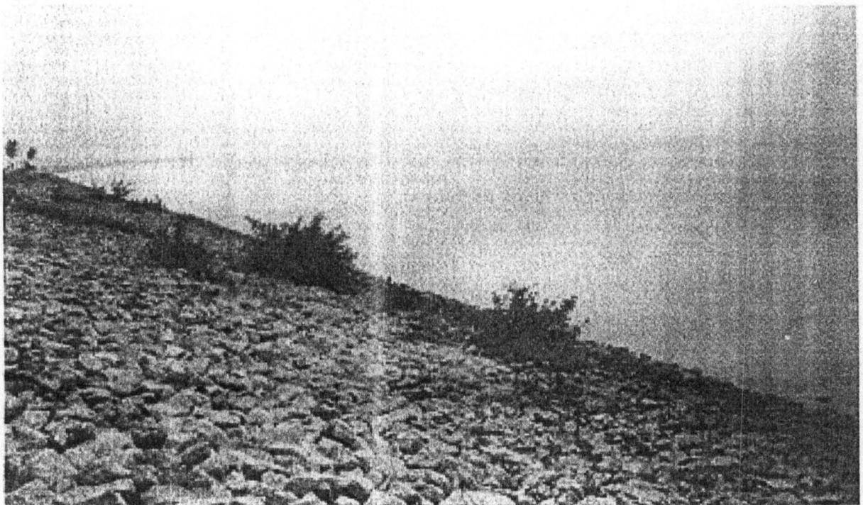
**PLATE NO18: PICTURE SHOWING SHRUBS ON THE UPSTREAM FACE OF THE EMBANKMENT.**
